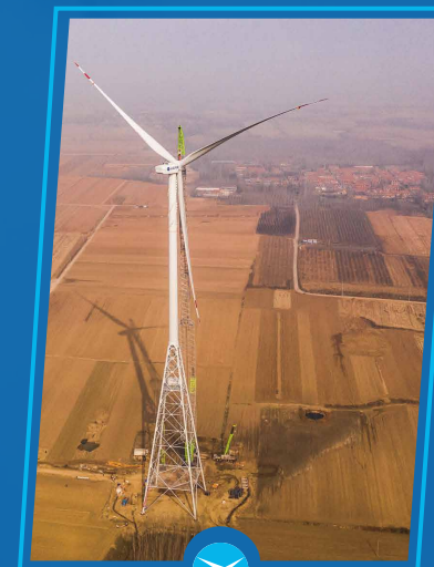
国内最高170m桁架式塔架 (2021年8月, 山东青岛)
